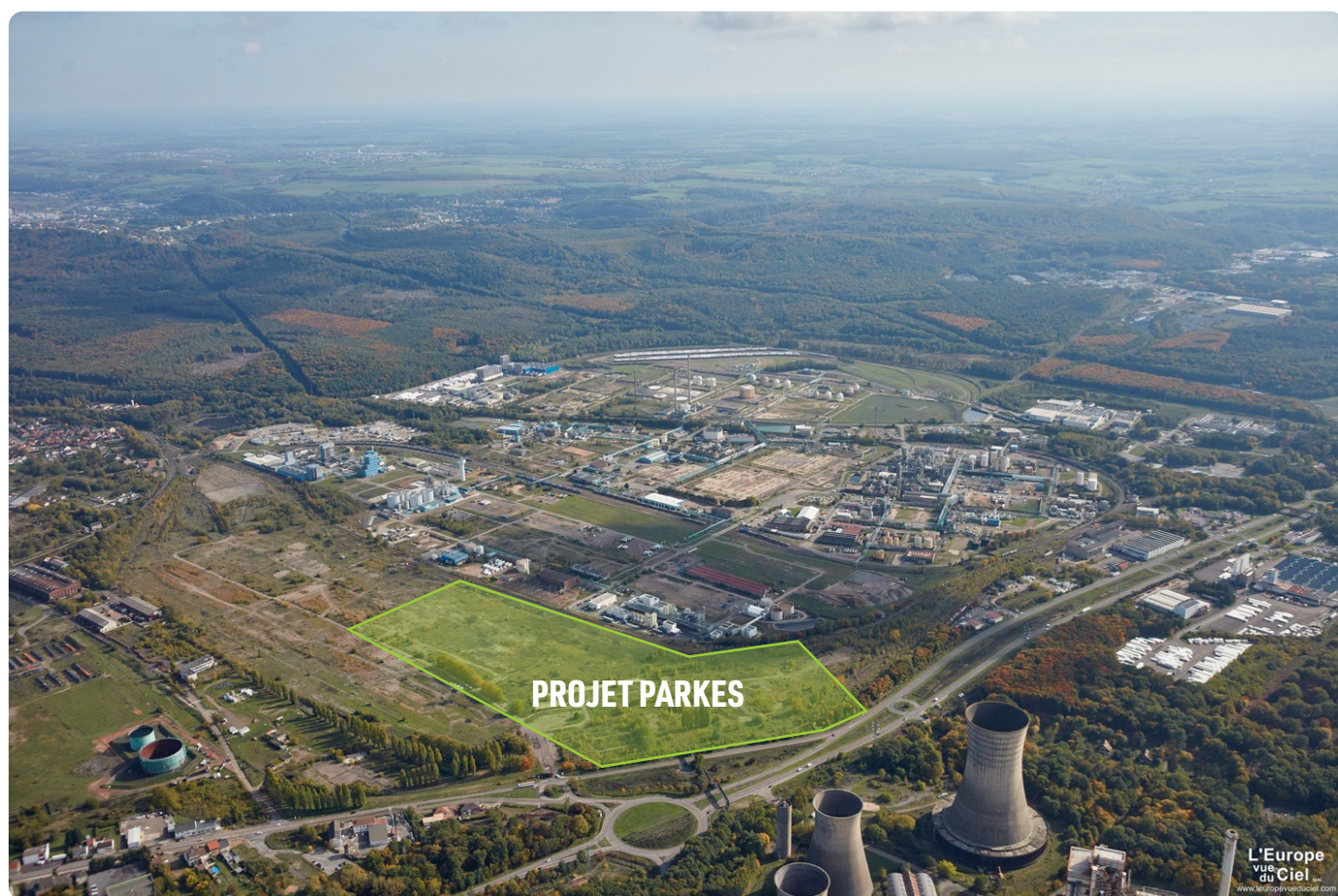
Figure 1 : Vue aérienne du site d'implantation 1 au sein de la plateforme Chemesis.
